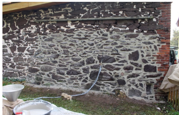
Bild 2: Sanierung gipshaltigen Mauerwerks auf der Basis des Bindemittels
